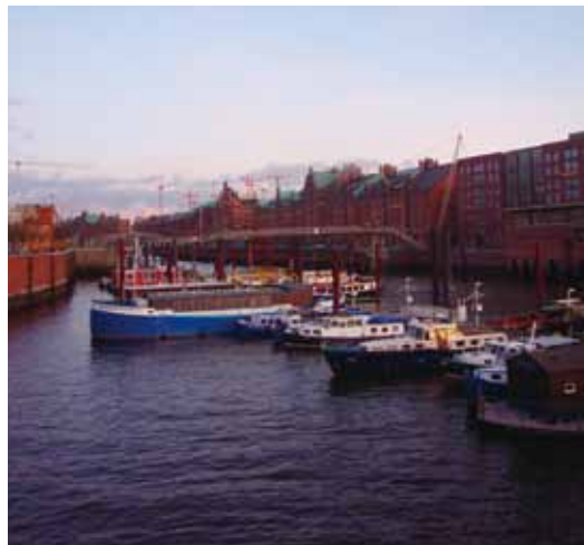
漢堡海港一角。磚紅色的建築群是港口倉儲區，因占地廣大，亦被稱為倉儲小城。
