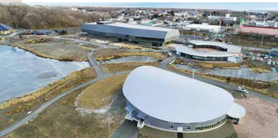
工事中のウポポイ（手前がシアター、奥が博物館）。 施工中的UPOPOY（前為劇場、後為博物館）。
